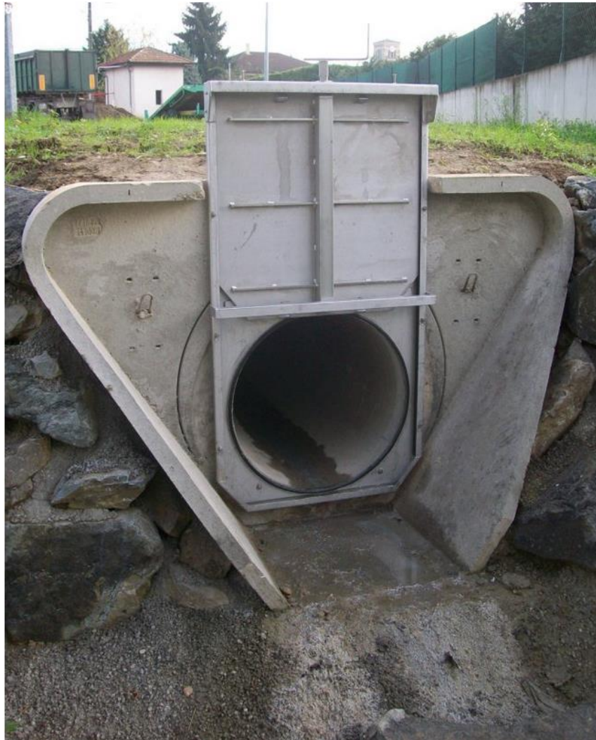
Figure 20 : Illustration d'une vanne guillotine
