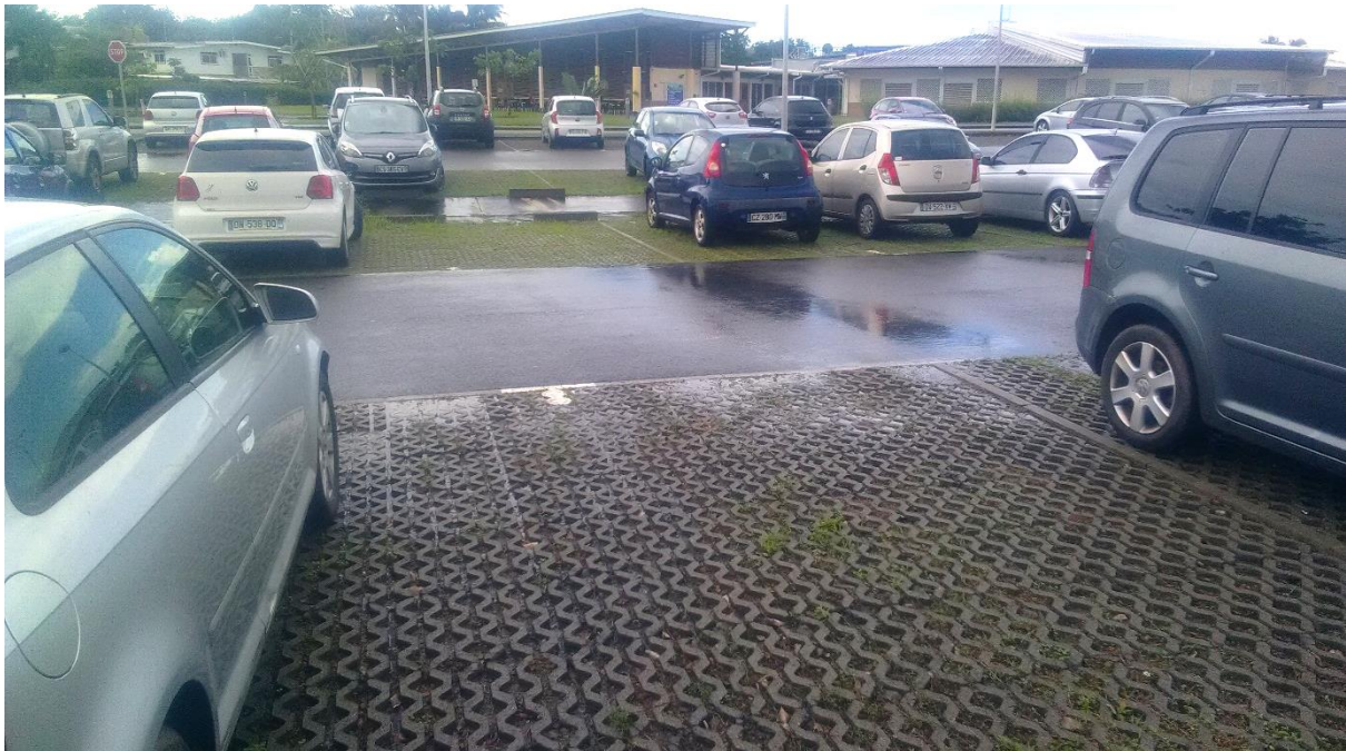
Figure 15 : Revêtement en dalles drainantes enherbées du parking du Quartier de la Madeleine
